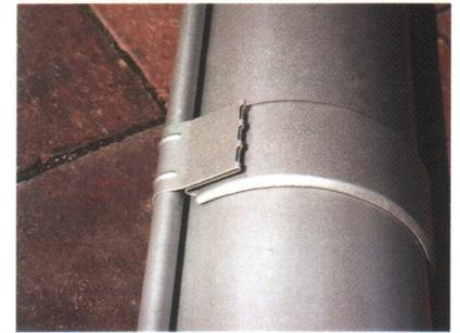
6. Устанавливаем края желобов друг против друга, соединяем их с помощью соединителей желоба и защелкиваем фиксатор.
