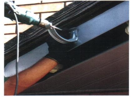
3. Компактный крюк желоба крепим к лобовой доске. Способ монтажа компактных крюков желоба см. в пункте 1.
