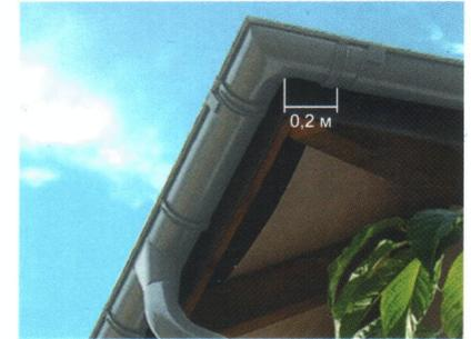
9. Поворотный угол крепится между двумя крайними держателями. Максимальное расстояние между держателями и поворотом лобовой доски - 0,2 м.
