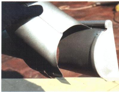
5. Устанавливаем воронку на выпиленное ножовкой отверстие. Загибаем язычки вокруг краев желоба. Закрепляем желоб в предназначенных для него крюках круглым краем наружу.
