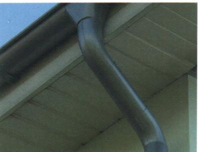
10. При большом расстоянии между водоприемником и стеной, используем колено с трубой необходимой длины.
